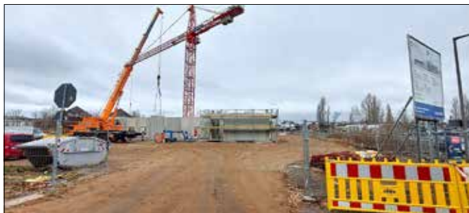
Die Kräne drehen sich auf dem Baufeld.
