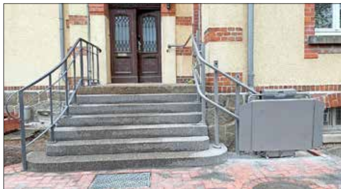
neue Außentreppe Pfarrhaus
