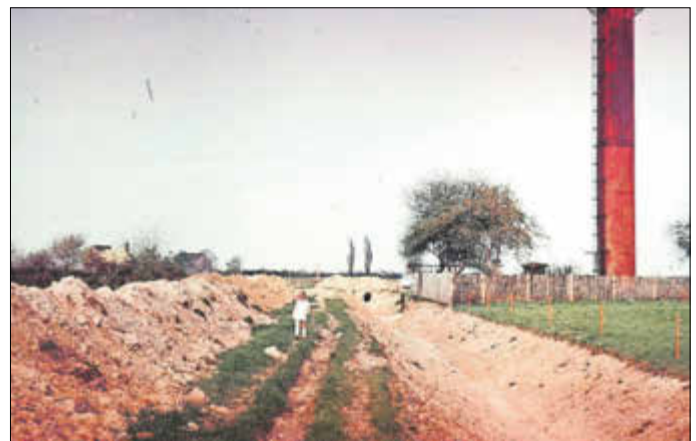
Mühlgrabenausbau Podelwitzter Weg 1994
