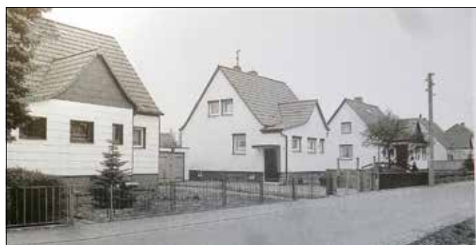
Foto 1996, modernisierte Siedlung, Friesenstraße
