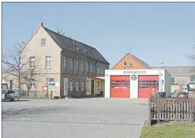
2000 Fertigstellung Feuerwehrgerätehalle / Berndt Böhlau / Archiv OR Seehausen
