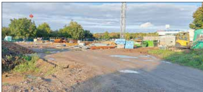
Blick auf die Baustelle in der Seehausener Straße (September 2022)
