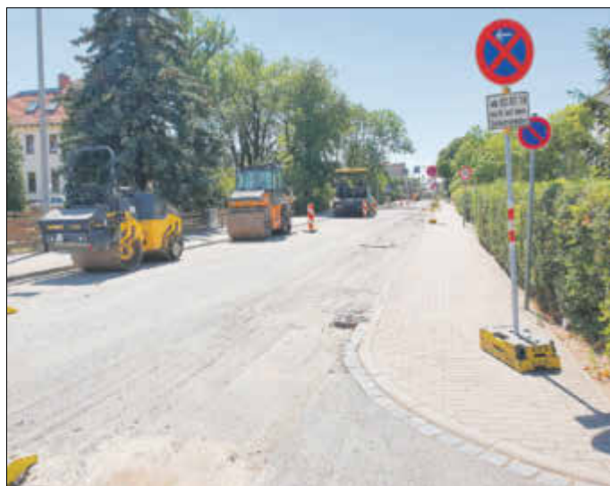
Seehausener Allee 2 2018 Sanierung Seehausener Allee / Berndt Böhlau / Archiv OR Seehausen
