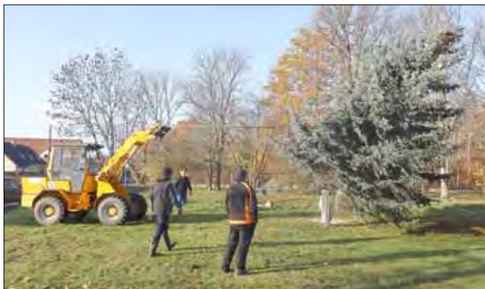
Einen Radlader braucht es beim Aufstellen schon.
